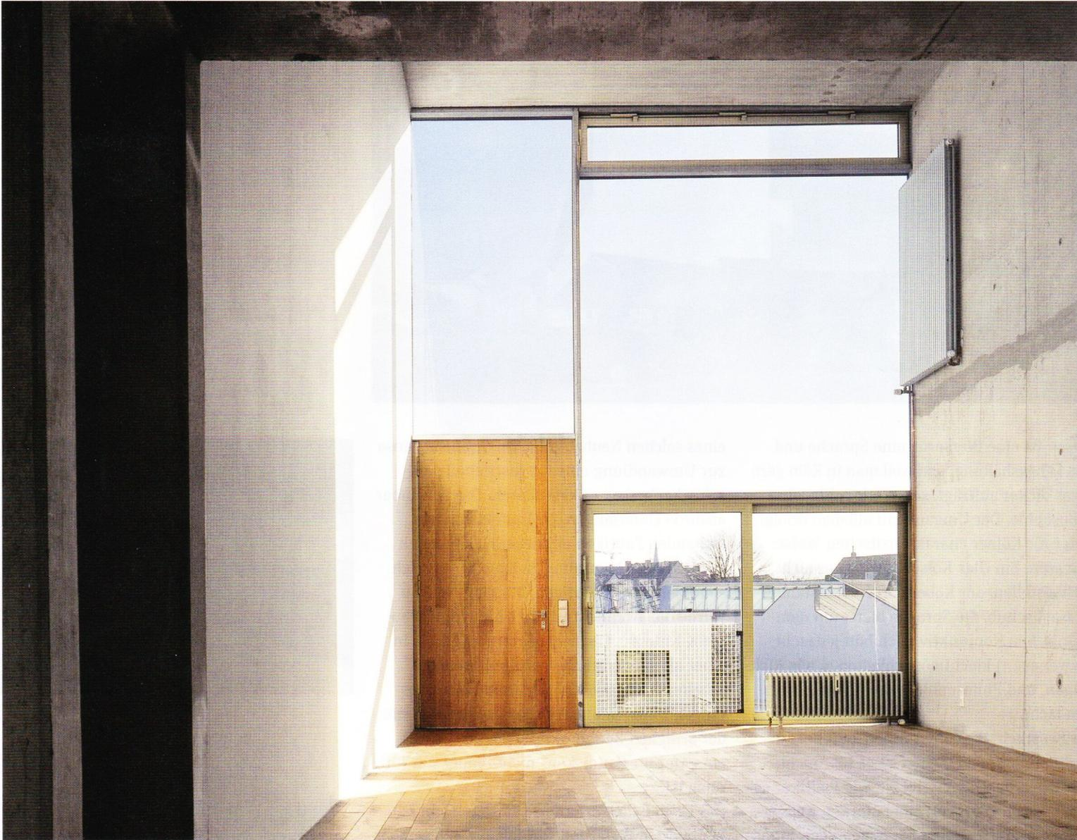
Der doppelgeschossige Teil der Einheiten ist so ausgestattet, dass bei Bedarf eine Galerie eingehängt werden kann. Der Ausbau blieb den Nutzern überlassen. Das Schema zeigt die Zuordnung des Außenraums zu den zwölf Einheiten.
